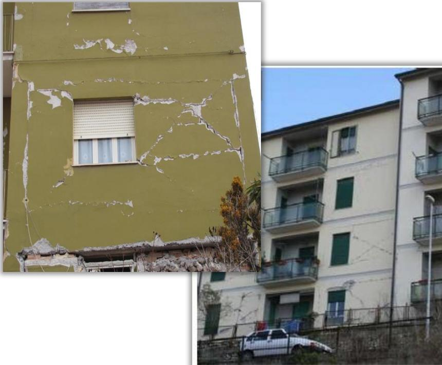
Fessure Diagonali sui tamponamenti di un telaio in c.a.
