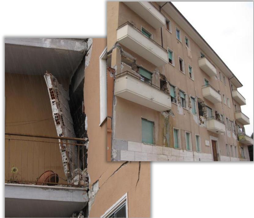
Espulsione del paramento esterno di tamponamento di un telaio in c.a.
